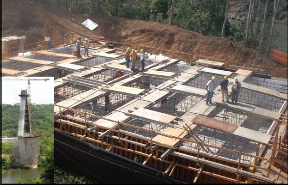
Proyecto: Puente Atirantado PR-148 Naranjito Elemento: Zapata Volumen: 638 m 3
