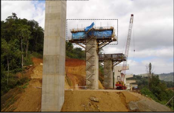
Proyecto: PR-10 Utuado - Adjuntas Elemento: Cabozales Volumen: 428 m 3
