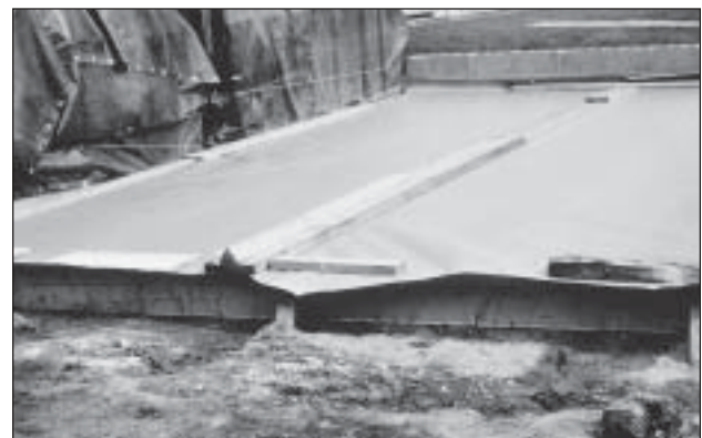
Losa cubierta con láminas plásticas ( lonas ) impermeables para curado.
